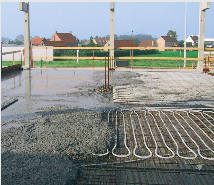
Rys. 11. Aktywna struktura budynku – budowa stropu pośredniego z systemem rur
